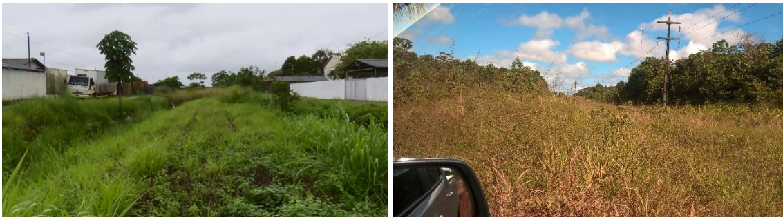
Figuras 15 e 16. Trecho de ferrovia completamente desativada em trecho urbano e no cruzamento com a Perimetral Norte
