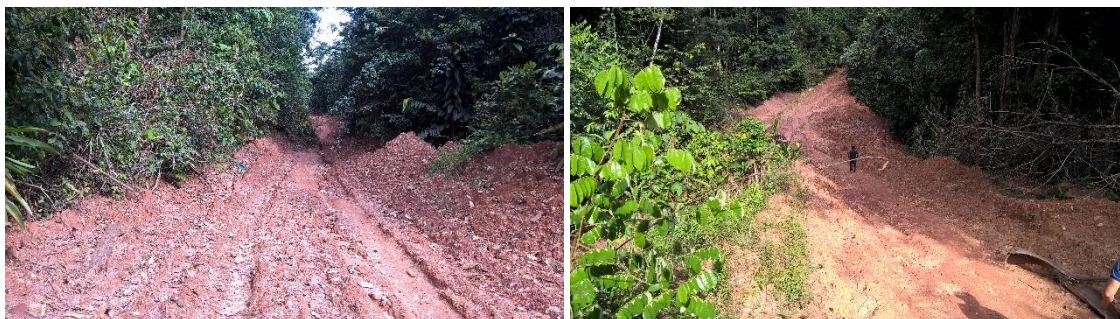
Figuras 31 e 32. Condições do ramal Porto da Serra
