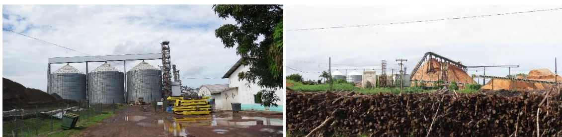
Figuras 25 e 26. Silos para armazenamento de granéis sólidos e terminal da Amcel
